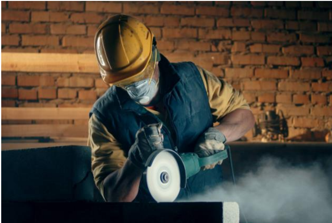
Slika 3. Radnik na cirkularu kod kojeg postoji velika vjerovatnoća za silikozu pluća, koristi ličnu zaštitnu opremu 10
